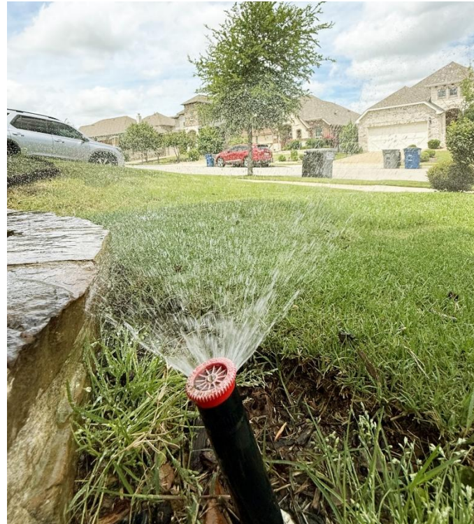
Replace or clean nozzles.
